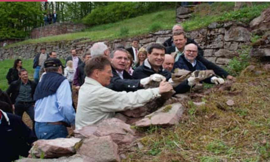
Umweltminister Dr. Markus Söder (Mitte) setzte zusammen mit hochrangigen Vertretern aus Politik, Verwaltung und Verbänden die ersten Steine der zu sanierenden Weinbergsmauern auf.
