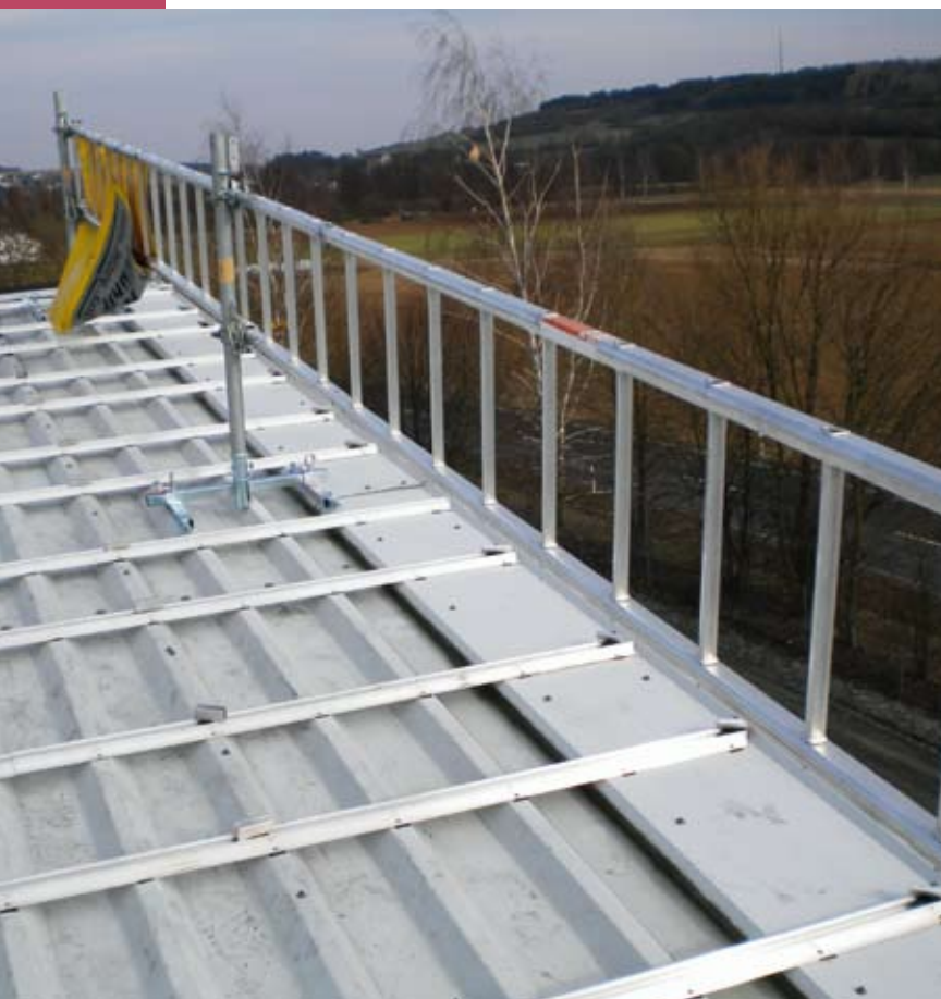
Absturzsicherung am Dachrand
