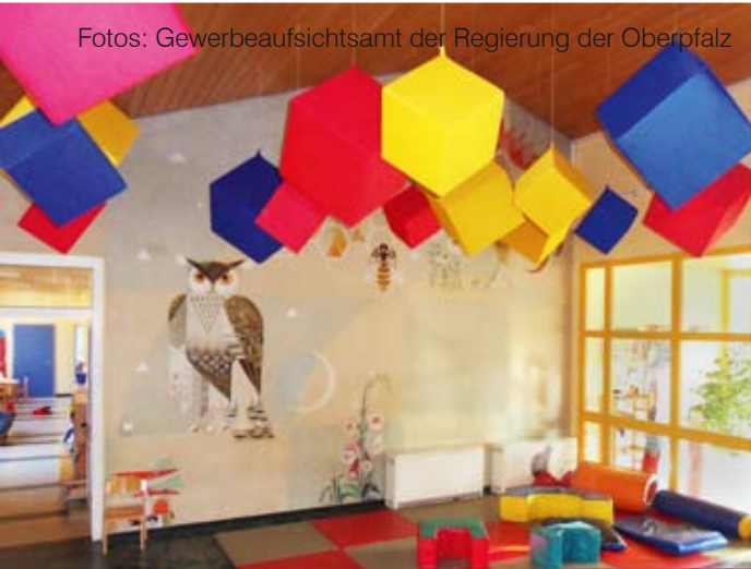
Schön gestalteter Gruppenraum mit Deckenelementen als Versuch zur Verbesserung der Raumakustik.
