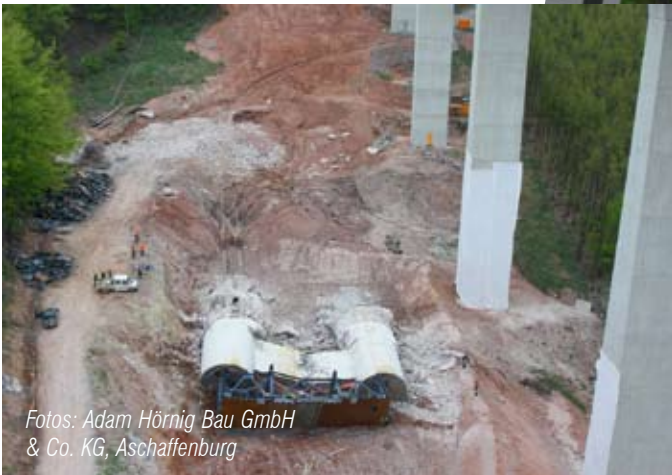
Sprengung des 5. Pfeilerpaares an der Haseltalbrücke
