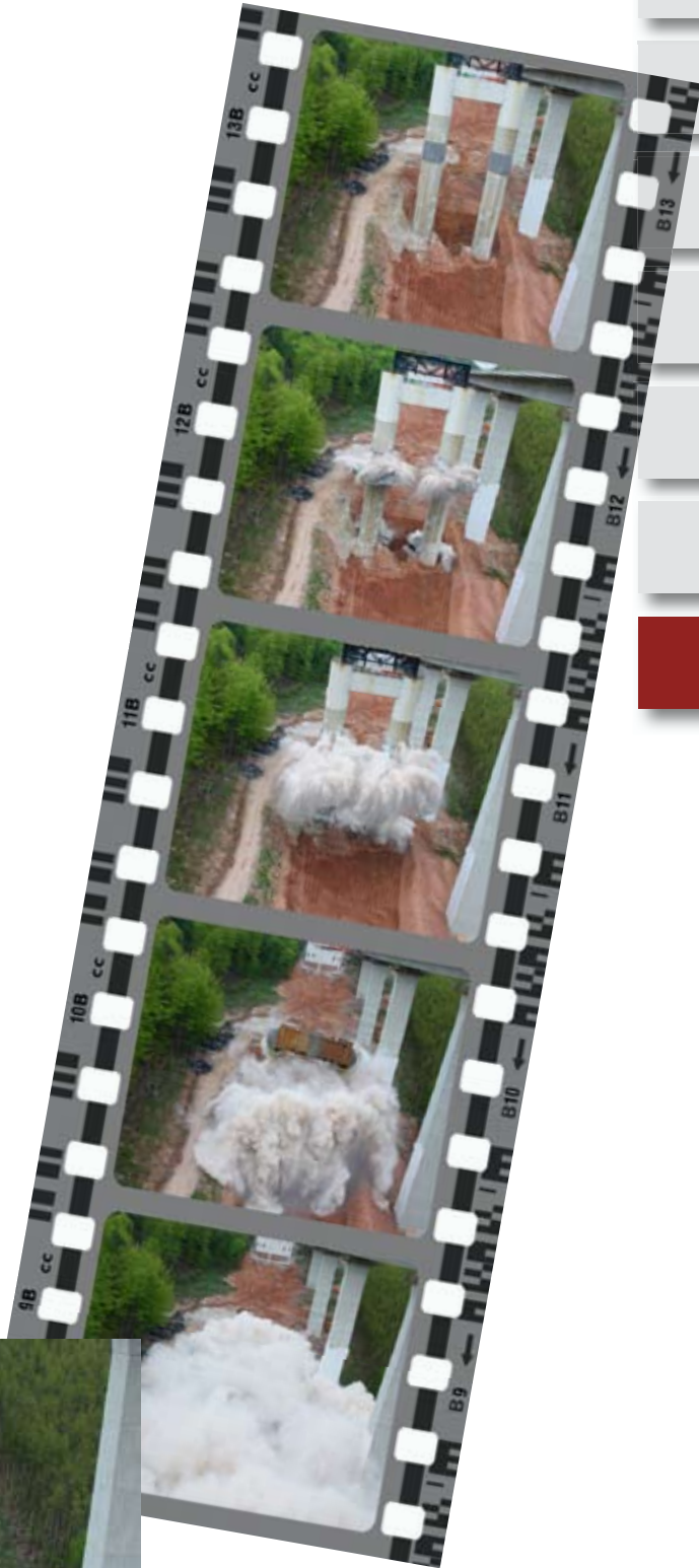
Sprengung des 5. Pfeilerpaares an der Haseltalbrücke
